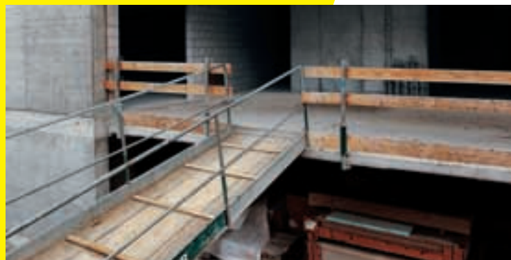
3 Des accès au chantier stables et sûrs.
