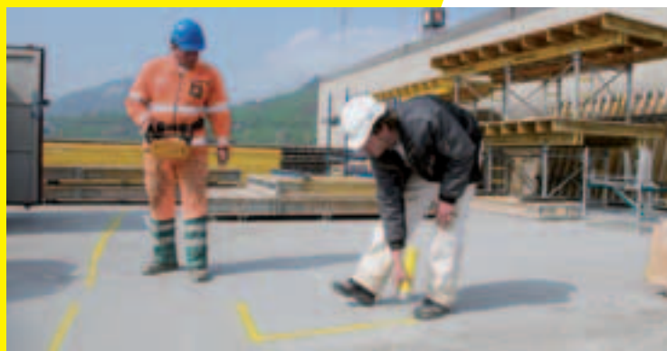
3 Delimitazione chiara delle aree di deposito.
