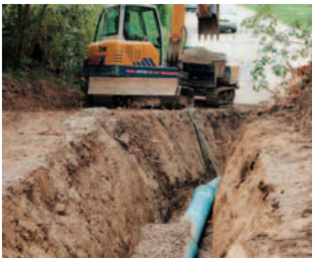
9 Etayer ou taluter dès 1,5 m de profondeur.
