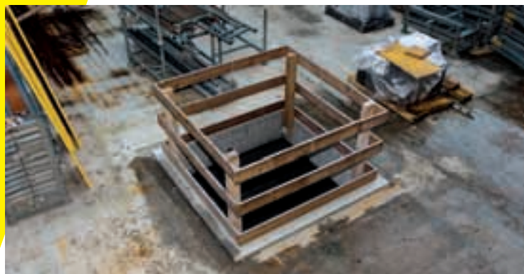
9 Absturzsicherung bei Bodenöffnung.
