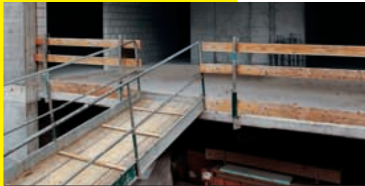
3 Stabiler und sicherer Baustellenzugang.
