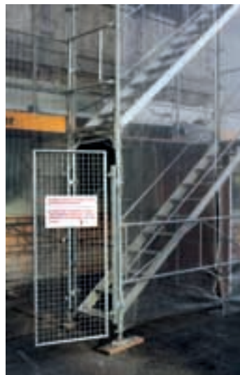
7 Sicherer Gerüstaufgang.
